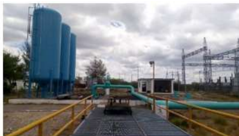
Cámaras de aire obra de toma y subestación eléctrica
