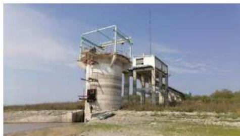
Obra de toma de la presa Vicente Guerrero
