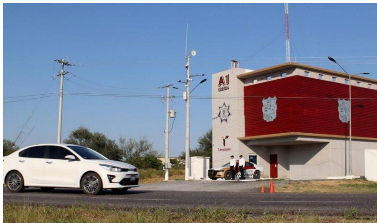
Figura 2.A.1. Infraestructura de estación segura en Tamaulipas
